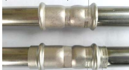
雙壓著接頭管件壓接完成品 (有雙邊有凸緣)
